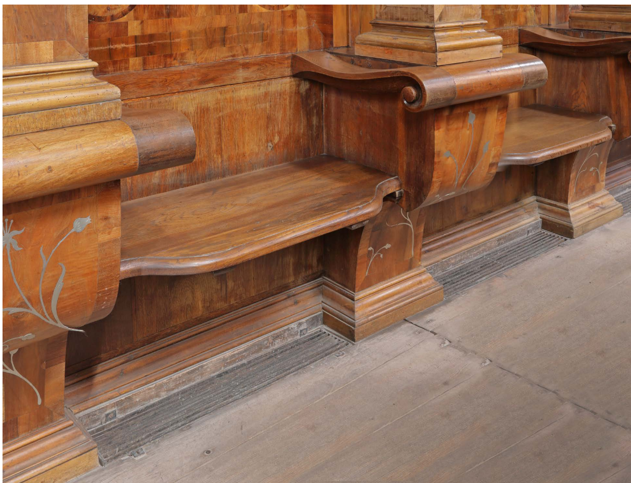
21. Prezbiterium katedry fromborskiej, kratki nawiewowe do ogrzewania ciepłym powietrzem systemu Pereta, pod siedziskami w stallach barokowych, 1907 r.
