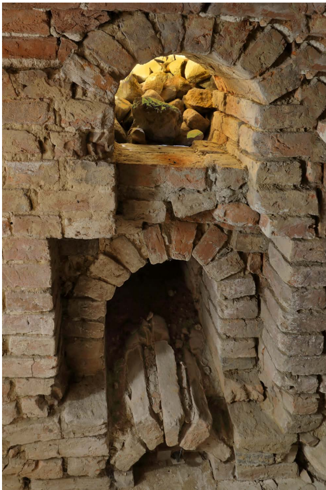
5. Szpital św. Ducha, przedsionek zachodni. Piec typu hypokaustum po stronie południowej – widoczne kamienie w komorze kumulującej ciepło.
