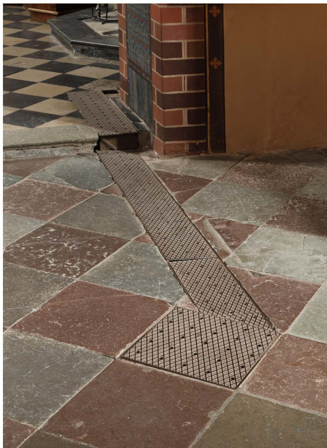
22. Katedra fromborska, posadzka w nawie głównej po stronie południowo-wschodniej, stalowe płyty z otworami nad instalacją grzewczą.
