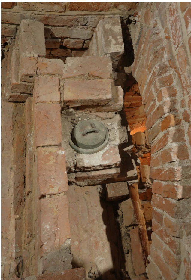
6. Szpital św. Ducha, przedsionek zachodni. Pokrywa na sklepieniu pieca nad komorą grzewczą.
